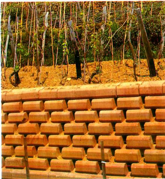
Fig. 3.5 - La riparazione può anche venire effettuata con materiale prefabbricato (facilmente reperibile e trasportabile) se alla praticità della posa in opera unisce un accettabile aspetto estetico.
