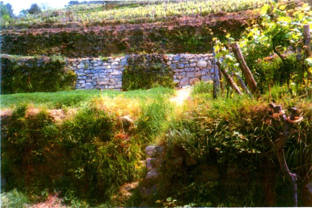
Fig. 3.4 - I muretti a secco a sostegno delle terrazze, costruiti nei secoli scorsi con tecniche totalmente manuali ed utilizzando pietre naturali del posto, devono essere oggetto di costante manutenzione per evitare di dover procedere a ricostruzioni sempre onerose ed esteticamente discordanti fino a che le intemperie e la vegetazione non ne favoriscono l'omogeneizzazione con i muri preesistenti.
