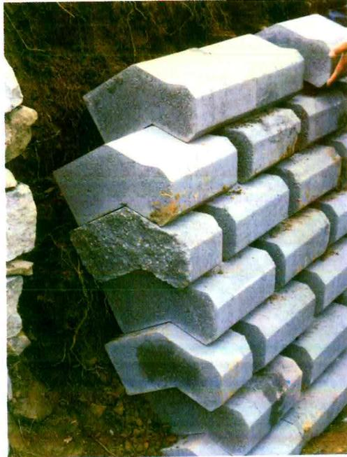
Fig. 3.7 - In caso di rovina, la ricostruzione viene eseguita utilizzando le pietre naturali, che richiedono molto lavoro e perizia per la collocazione (a sinistra), a differenza degli elementi prefabbricati componibili che vengono posati facilmente e rapidamente.
