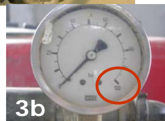
3 - manometri non funzionanti (3a) o con intervallo di lettura e fondo scala non adeguati (3b)
