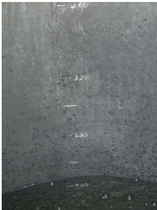
Fig. 38 – Indicatore di livello presente all'interno di un serbatoio in plastica.
